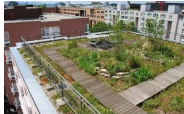
Agence de l'environnement de Karlsruhe avec système de végétalisation riche. Source : Ontigrün
