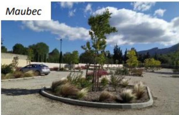
Parking perméable stabilisé
